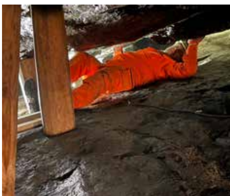
Oprava důlních výztuží v úseku za portálem štoly.
