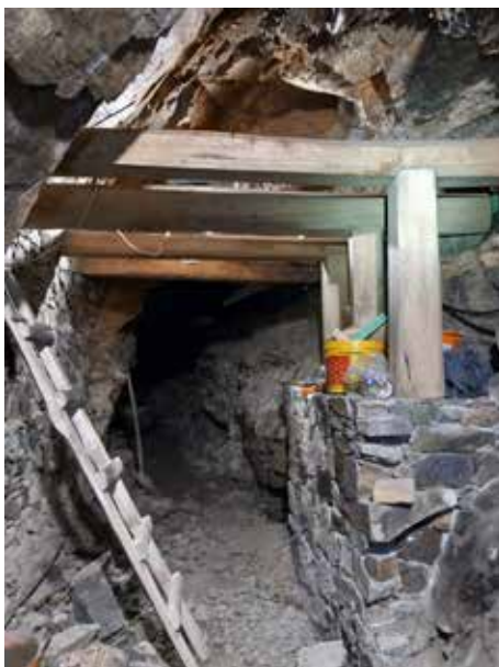
Oprava důlních výztuží v úseku za portálem štoly.
